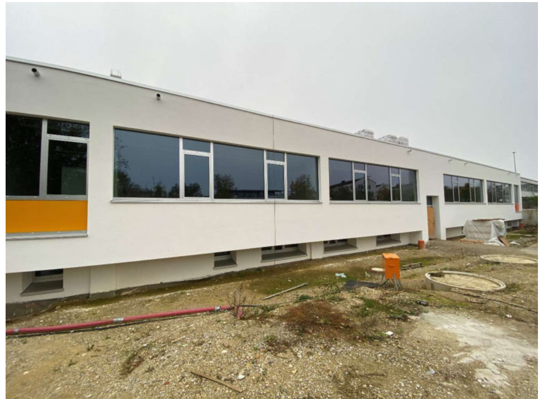
WDVS an Fassade und neue Fensterelemente
