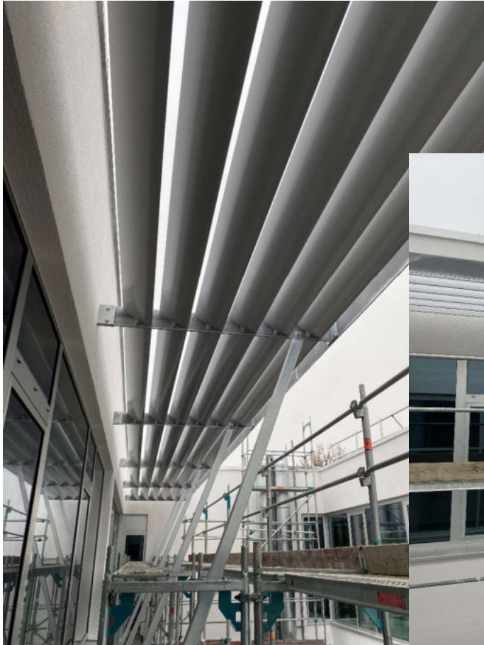
Montage feststehender Sonnenschutz
